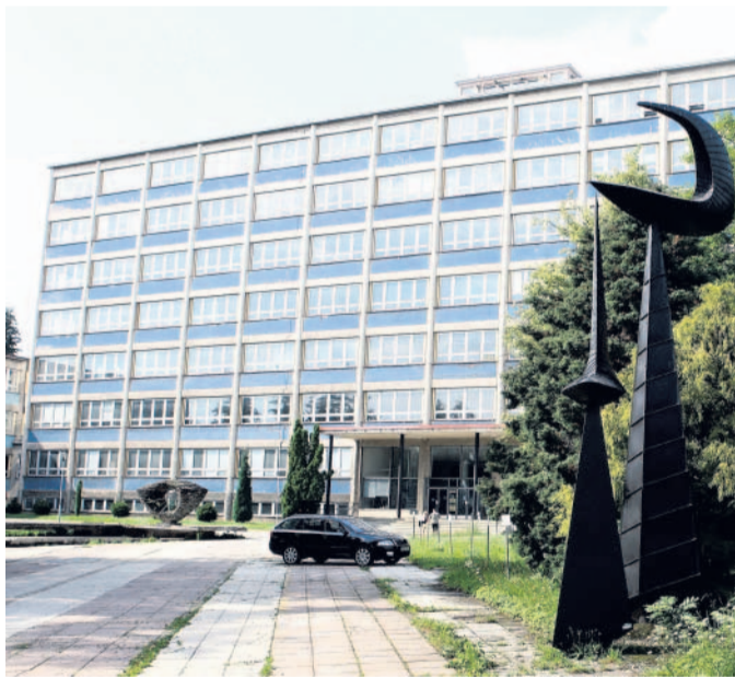
Bižuterie Dominantou Bižuterie je osmipodlažní výrobní objekt.
