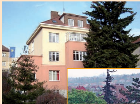
Prvorepubliková samostatná vila se čtyřmi prostornými byty a nebytovými prostory.
